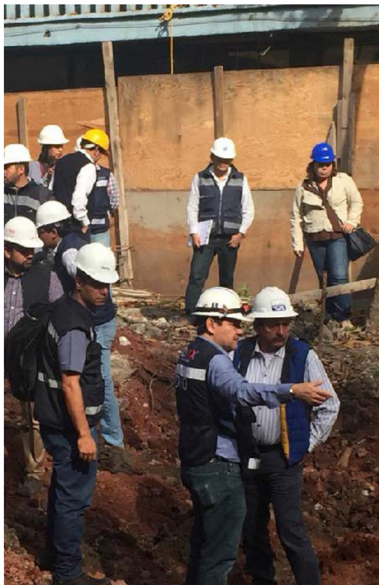
FOTO: ARG. RODOLFO SÁNCHEZ ZARAGOZA
